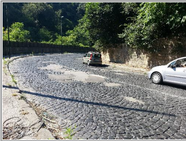
Colmata di buche e avvallamenti con bitume.
