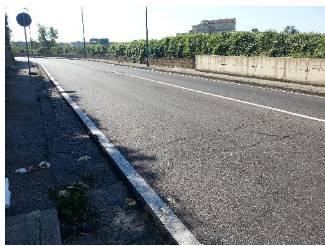
Fessurazione trasversale
